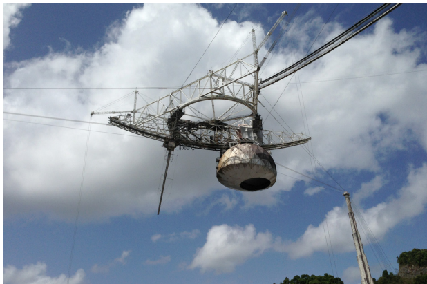
Fig.2. Suspendues à quelque 150 m de haut, les têtes d'émission/réception sur leur rail en arc de cercle. À gauche, la ligne d'émission/réception pointe vers le bas et à droite se trouve la demi-sphère du système grégorien (crédit T. Ulich).
