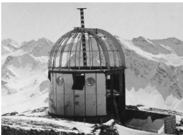
Fig.1. Remontage de la coupole.
