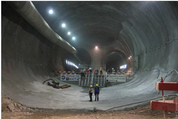
Le tunnel de base du St Gothard.
