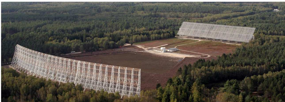
Fig.1. Principales caractéristiques du grand radiotélescope décimétrique de Nançay. En bas une photographie aérienne des structures des miroirs. Le miroir de droite est inclinable pour pointer en altitude, le miroir de gauche est fixe, avec la forme d'une portion de sphère pour concentrer le rayonnement collecté vers le foyer mobile au centre. Le foyer et ses instruments récepteurs se déplacent le long d'une voie est-ouest de 80 mètres, permettant le suivi d'une source astronomique pendant une heure de part et d'autre de son passage au méridien. (Copyright Observatoire de Paris).
