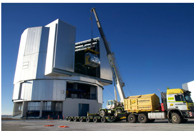
Fig.2b. Mise en place de l'instrument sur le télescope. Crédits : E. Le Roux / UCBL.
