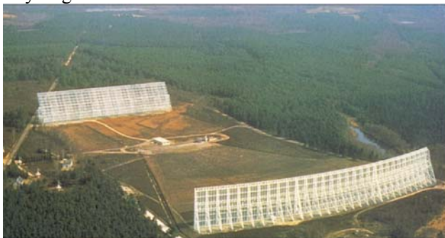
Fig.6. Le grand radiotélescope de Nançay. Il comporte un miroir plan mobile autour d'un axe est-ouest, formé de dix éléments, mesurant 200 × 40 m. Il envoie les ondes radio de la source vers le miroir concave fixe de 300 m × 35 m, qui les concentre sur des antennes situées entre les deux miroirs. Ces antennes se déplacent sur un chariot de façon à suivre l'image de la source pendant environ 30 minutes de part et d'autre de son passage au méridien.
