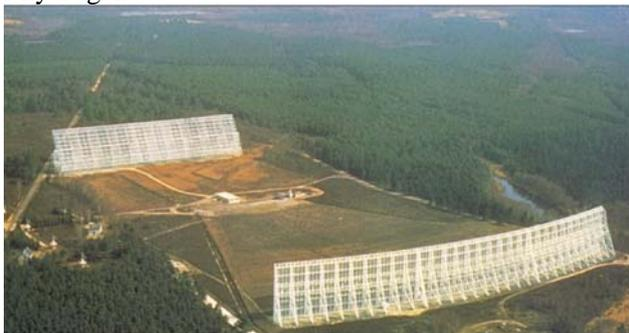
*Fig.6. Le grand radiotélescope de Nançay. Il comporte un miroir plan mobile autour d'un axe est-ouest, formé de dix éléments, mesurant 200 × 40 m. Il envoie les ondes radio de la source vers le miroir concave fixe de 300 m × 35 m, qui les concentre sur des antennes situées entre les deux miroirs. Ces antennes se déplacent sur un chariot de façon à suivre l'image de la source pendant environ 30 minutes de part et d'autre de son passage au méridien.*
