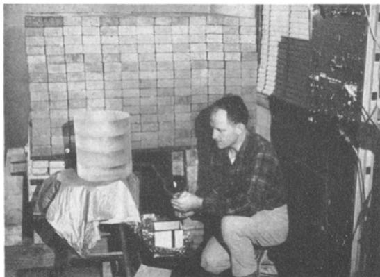
Fig 3 : Dans cette scène, extraite du film, le docteur Smith est montré en train d'assembler le détecteur. Le blindage en fer est dans l'arrière plan et une partie de l'électronique utilisé peut être vu sur la droite.
