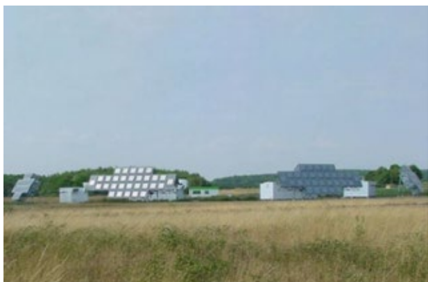
Fig.1. Émetteurs du radar GRAVES, situé entre Dijon et Vesoul. Fréquence d'émission à 143,05 MHz.
